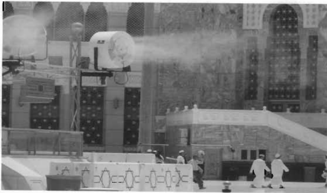
جانب من مشروع التبريد الضبابي بالمرابح بساحات الحرم المكي الشريف
